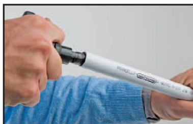
Kalibrálja a csövet a megfelelő szerszámmal.
