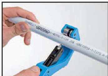
Derékszögben vágja el a csövet.
